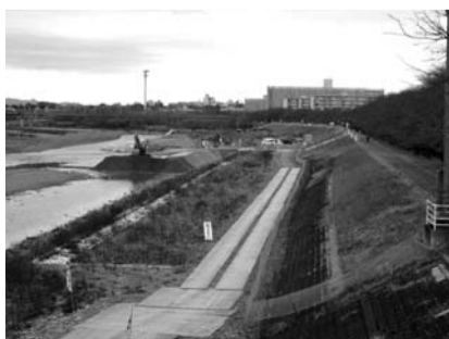
▲南田園地区で行われている護岸工事
