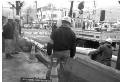
▲市内の工事現場の様子
