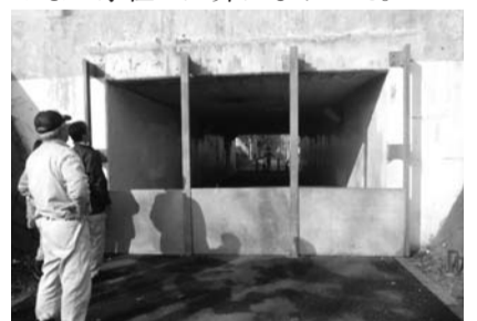
▲水害防護壁設置の様子
