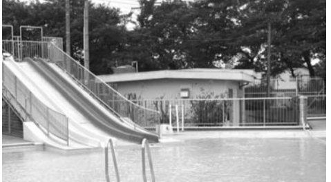
▲指定管理となった市営プール
