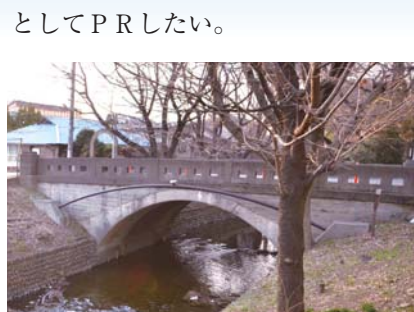
▲現存する最古の道路れんがアーチ橋の日光橋
