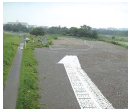
▲多摩川中央公園付近の護岸工事の様子
