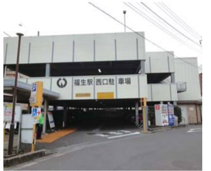
▲杭基礎工法の福生駅西口駐車場
