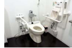
新庁舎のだれでもトイレ
