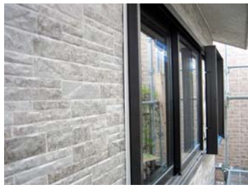
外壁断熱、断熱サッシ、複層ガラスを設置した住宅
