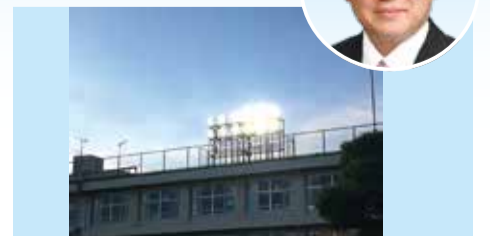
▲LED化した福生第一小学校の校庭照明
