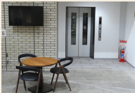
▲玄関ホールに新設したエレベーター
