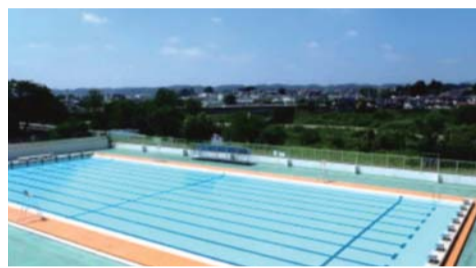
▲福生市営プール(50mプール) 外観
