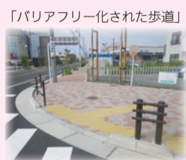
「バリアフリー化された歩道」
