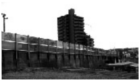
工事に向けての準備が始まった武蔵野陸橋
