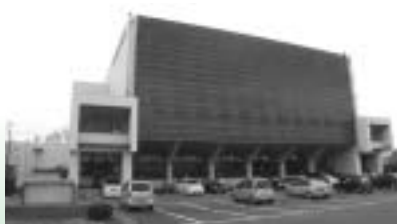
▲工事が予定される中央体育館
