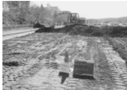
▲南公園野球場の復興工事
