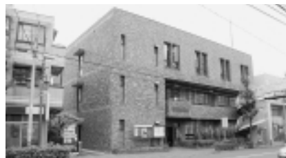
▲エレベーター設置が望まれる商工会館
