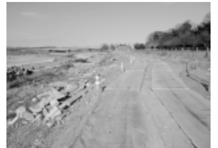
▲福生南公園護岸工事
